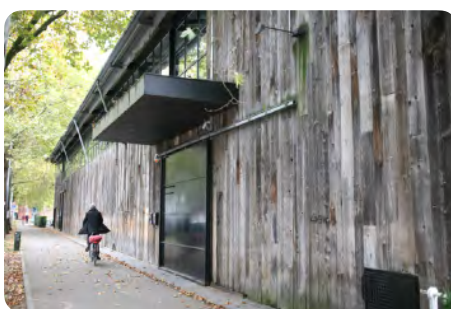
Réemploi de 800 m 2 de barnwood en bardage extérieur et lambris intérieur. Quay01 (K-nal), Bruxelles (BE) © Jean-Paul Hermant architectes https://opalis.eu/fr/projets/bardage-quay01-k-nal
