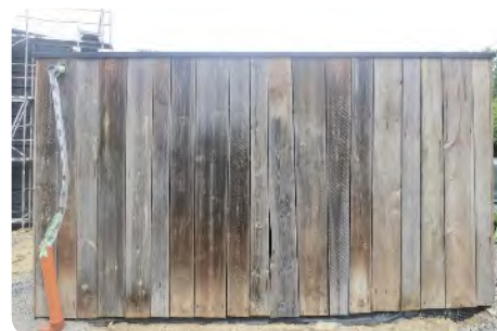
Réemploi de 800 m 2 de barnwood en bardage extérieur et lambris intérieur. Quay01 (K-nal), Bruxelles (BE) © Jean-Paul Hermant architectes https://opalis.eu/fr/projets/bardage-quay01-k-nal
