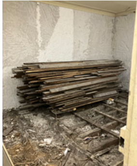
parquets en chêne récupérés (env. 50 m 2 ) *dimension d'un parquet : 10cm (l) x 2 à 3m (L) x 2cm (ep.)
