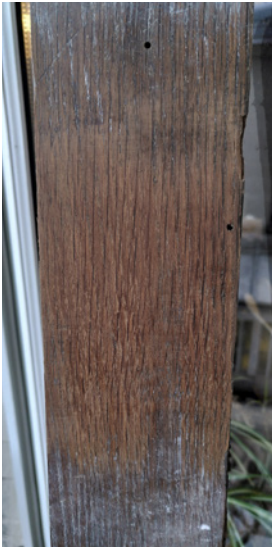
parquets en chêne récupérés (env. 50 m 2 ) *dimension d'un parquet : 10cm (l) x 2 à 3m (L) x 2cm (ep.)
