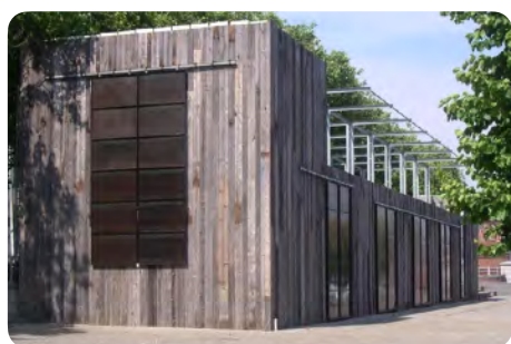
Réemploi de 800 m 2 de barnwood en bardage extérieur et lambris intérieur. Quay01 (K-nal), Bruxelles (BE) © Jean-Paul Hermant architectes https://opalis.eu/fr/projets/bardage-quay01-k-nal
